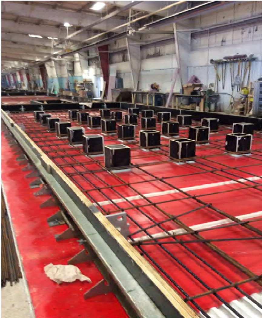
Panel 11W-001 Ready for Pour
